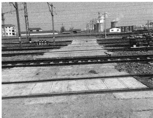
图 1-4 施工专用通道
