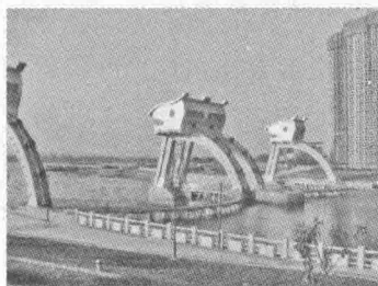
图4 南京三汊河口闸挡水
