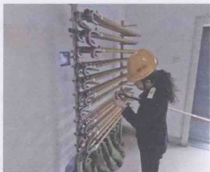
图 1-5 接地杆状态检查
