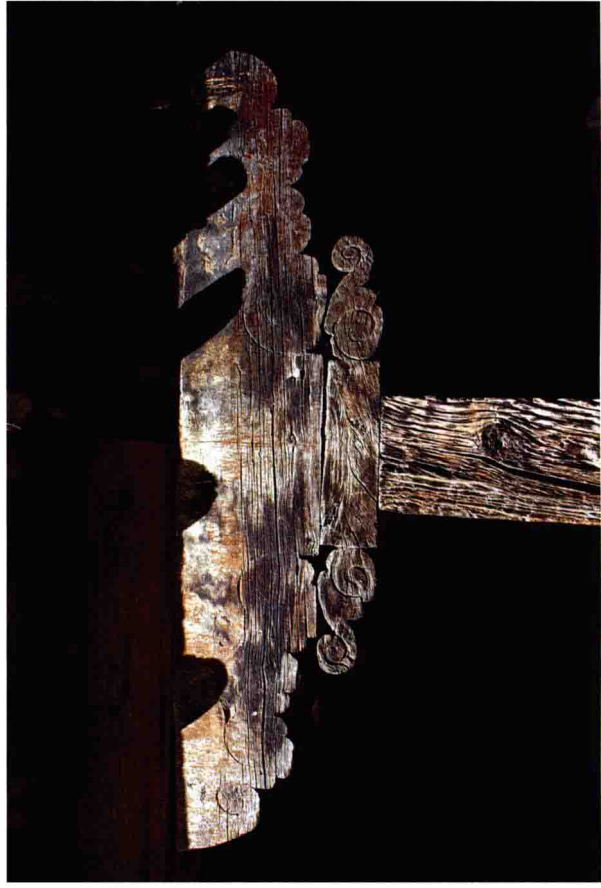
殿前廊托木构件
