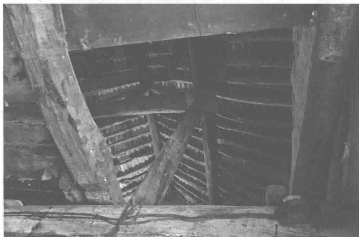
图七 常合发宅低梁高瓜柱结构
