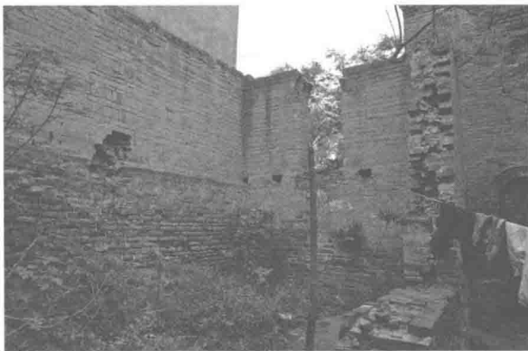
图五 下砖上坯结构(刘伍元宅的厢房)
