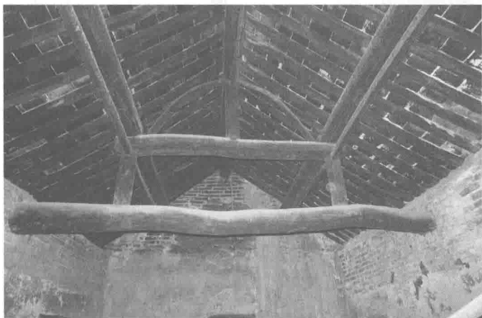
图六 五檩抬梁式构架
