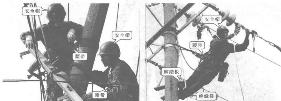
图 1-8 电工维修人员进行实际作业时的安全防护措施。
