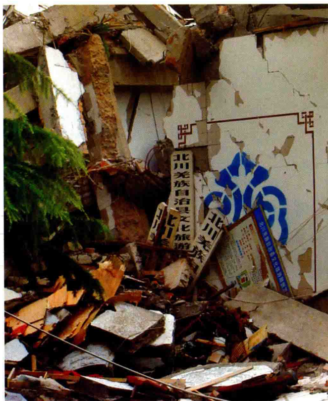
县文化旅游局、新闻出版局办公大楼在地震中垮塌
