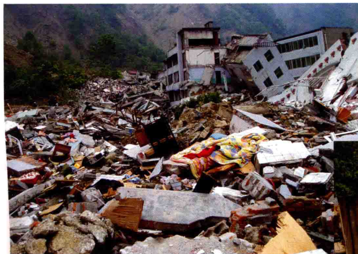
新华书店办公大楼和售书大楼倒塌，宿舍被埋，职工九人遇难，仅存3人，其中2人受伤，16名家属遇难，经济损失达3680万元。
