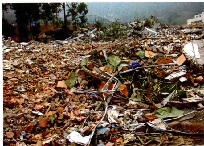
倒塌的县影剧院
