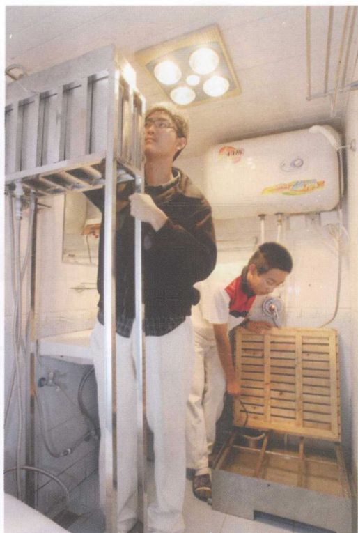
北师大实验中学的同学在卫生间安装 回收利用洗澡水冲厕设备
