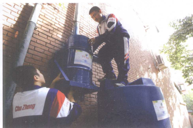
北京八大处中学的同学在社区安装自己设计的雨水沉淀装置
