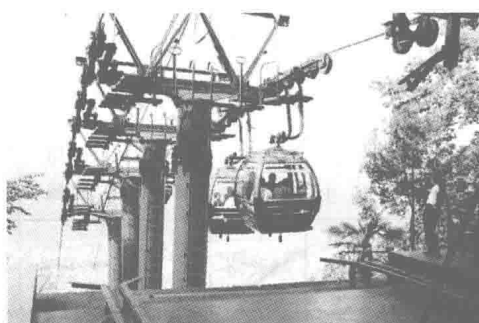
图 1-6 客运架空索道
