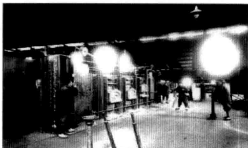
▲ 江南制造局钢厂的西门子 15 吨“马丁”平炉，钢材质量达到碳素钢年代的最高标准。
