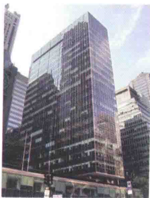
利华大厦（Lever House）照片。
