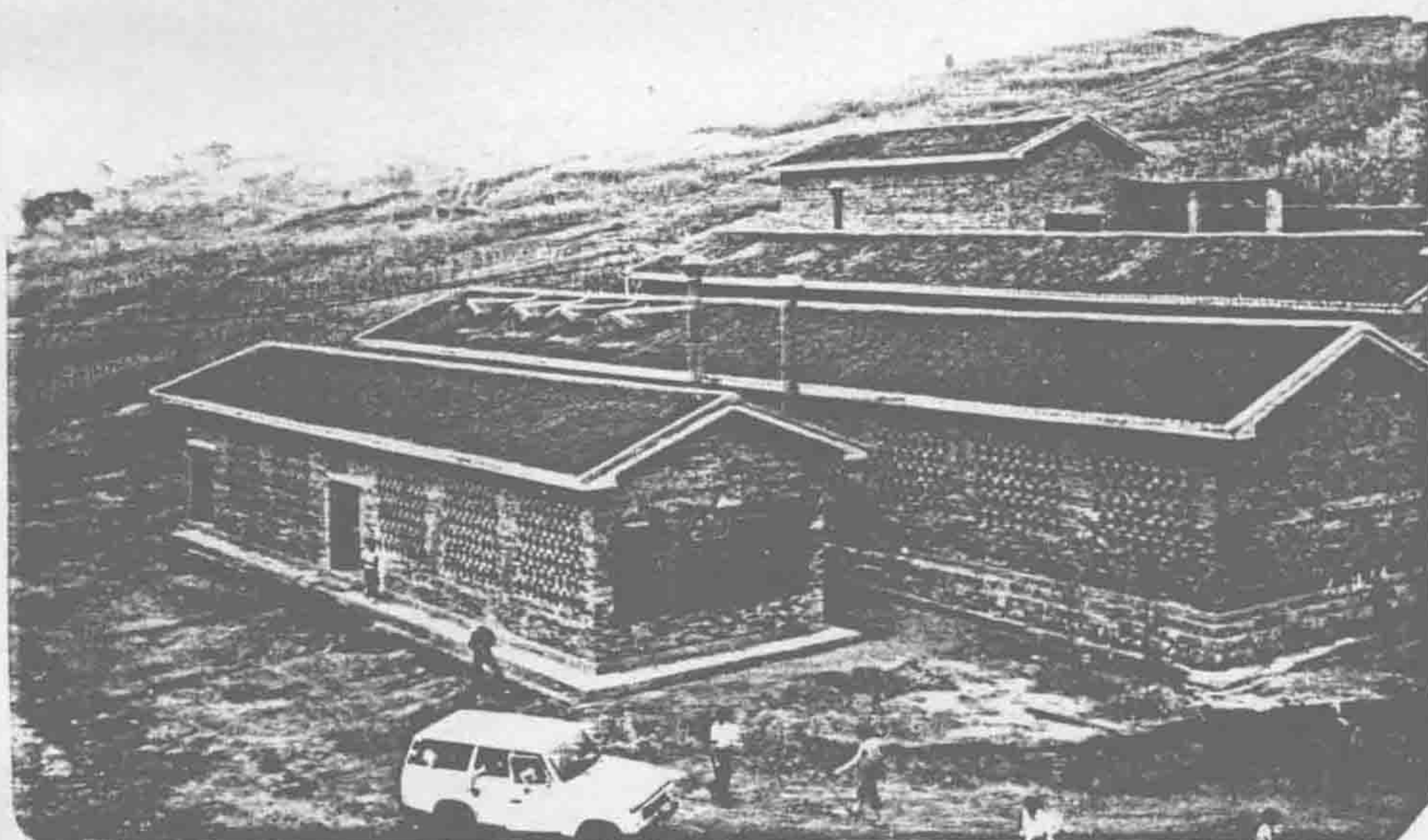
十二、邻水县长城蓄电池厂全貌
