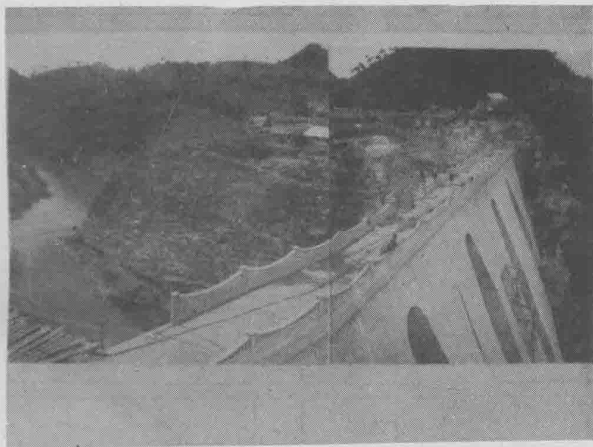
花溪水库大坝竣工（贵阳市水利局供稿）
