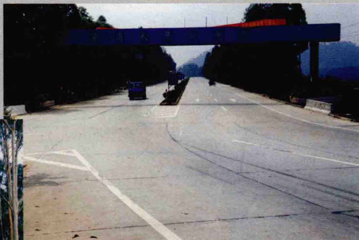
扩建后的萝南公路
