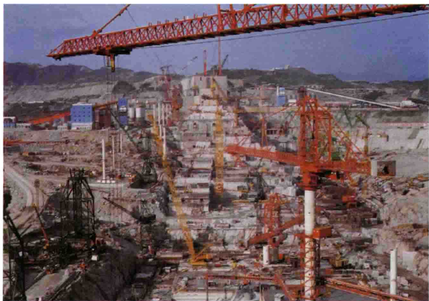
1999: 开挖、浇筑、手段安装、系统完善齐头并进
