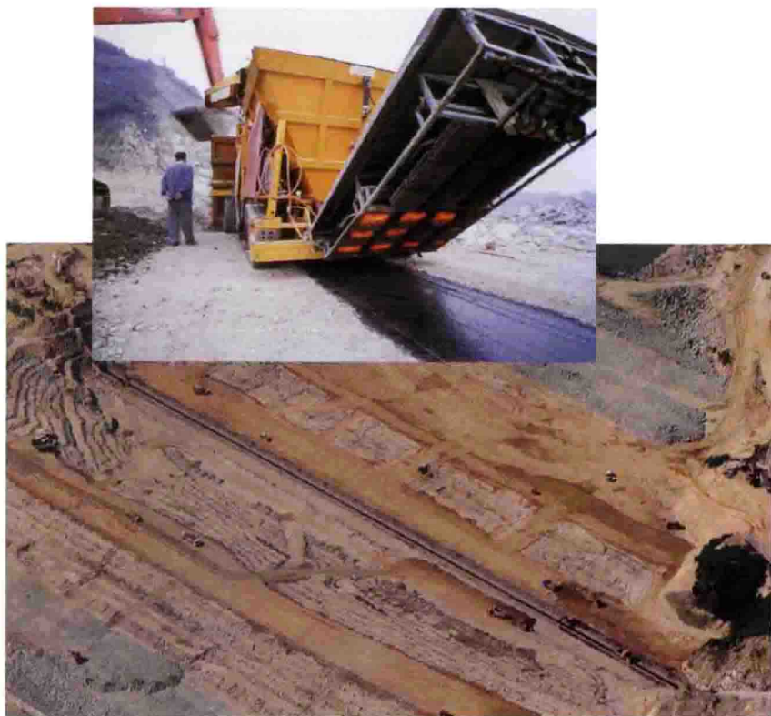
茅坪溪防护大坝鸟瞰图及沥青混凝土芯墙浇筑施工
