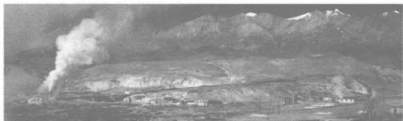
西藏羊八井地热发电厂，2010年3月
