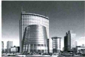
图1-4 某大型购物商场外观
