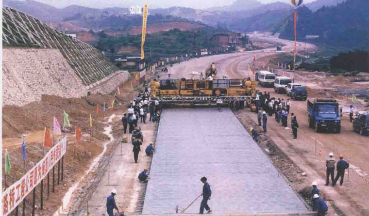
漳龙高速公路建设工地
