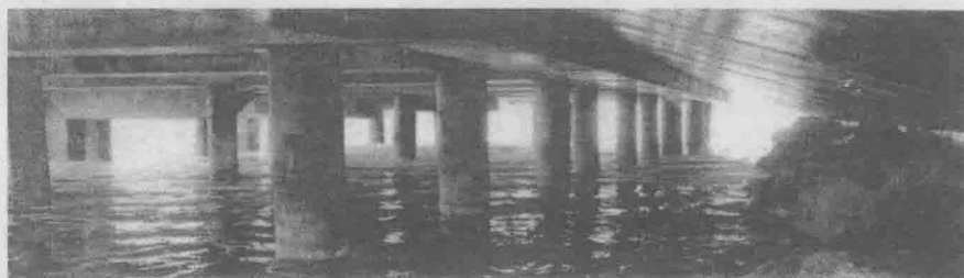
图 1.2 开放式混凝土结构仍然是挪威沿岸港口结构中最普遍的形式
