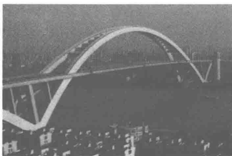
图 0-3 上海卢浦大桥
