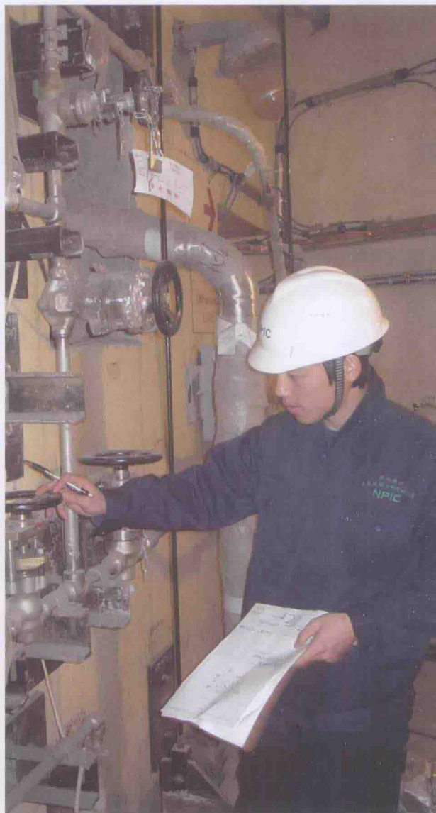
设计院现场队人员现场勘察
