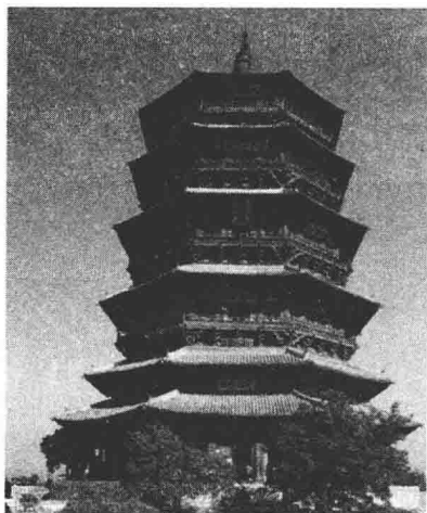
图 1-10 山西应县木塔
