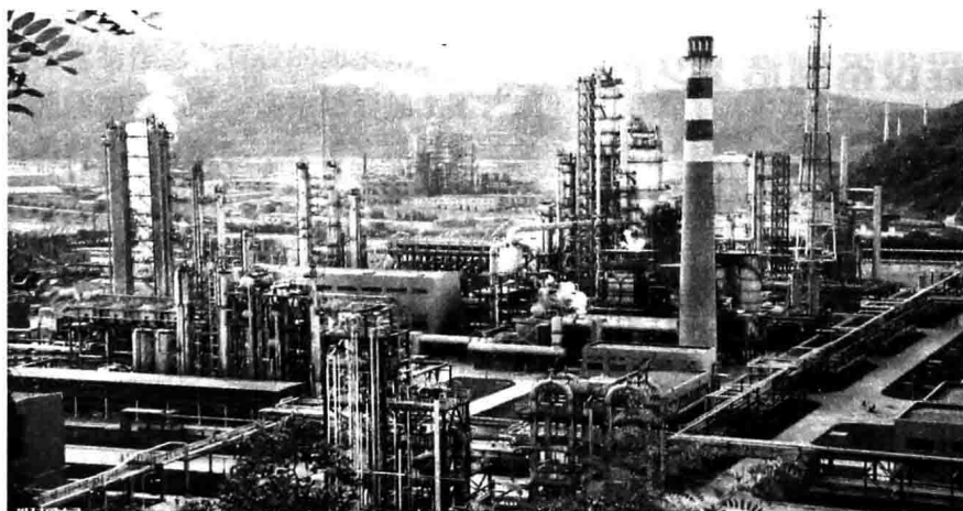
图 0-1 过程装备(过程工业的工厂一角)
