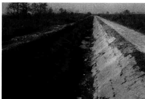
图 1-8 渠道衬砌板滑塌破坏情况
