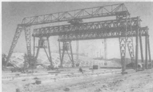
图 1-1-9 桁架结构装卸桥
