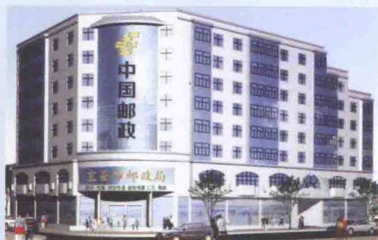
福绥路邮政大楼（1999年重建）
