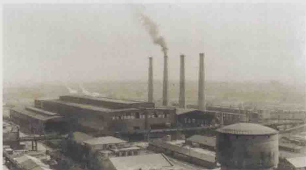
成都无缝钢管厂原平炉车间
