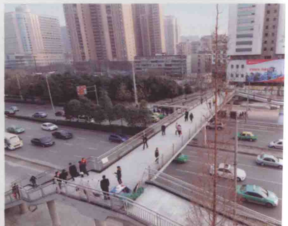
新建的二环路玉林南街人行天桥
