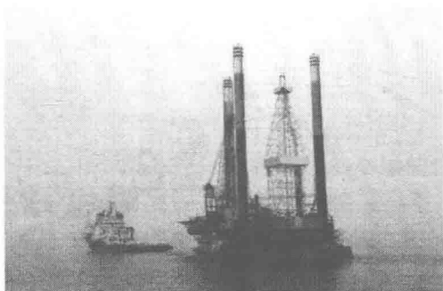
图 1.3 自升式平台拖航工况
