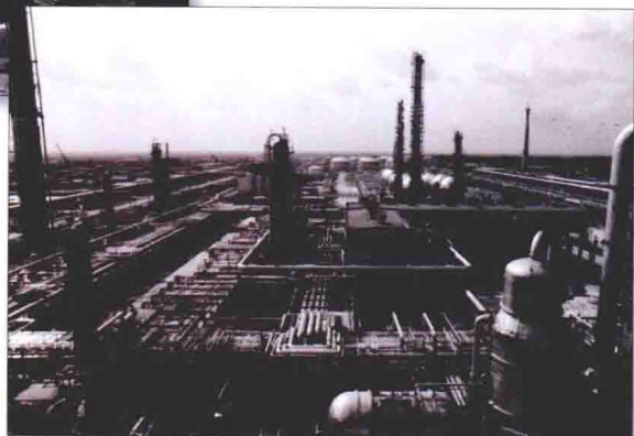
1987年9月，扬子乙烯 一期工程竣工投产
