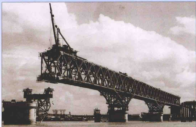
20世纪60年代，南京长江大桥施工现场
