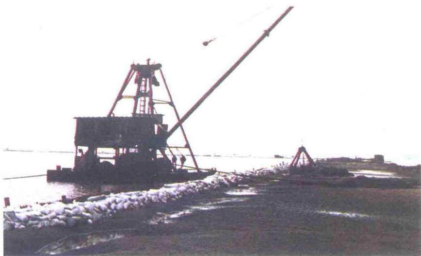
● 1993年，中山市横门垦区围垦工作现场
