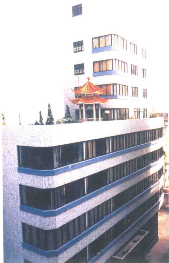
● 1985年6月12日，省政府发出通知，决定组建广东省国土厅，成为国内第一个实行城乡土地、地政统一管理的省级国土管理机构。图为位于广州市德政北路的省国土厅机关大楼外景
