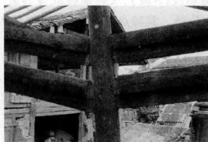
图 1.14 木结构破坏
