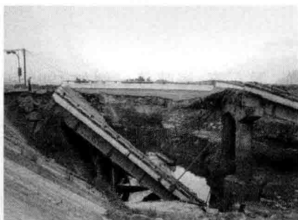
图 1.7 桥梁滑落
