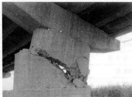
图 1.6 桥墩斜裂缝
