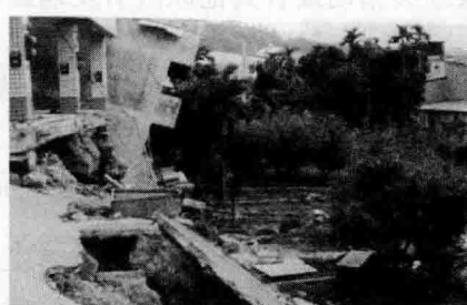
图 1.12 地基隆起导致建筑物破坏
