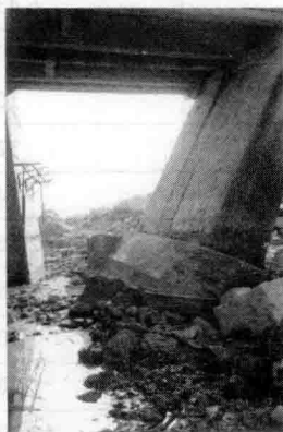
图 1.5 桥梁基础整体翻转
