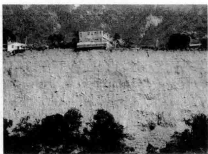
图 1.3 地震引起的山体滑坡
