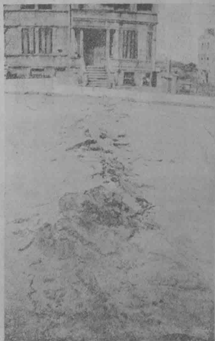
舊金山地震後街道破裂之狀況
