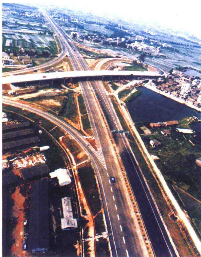
● 1989年建成通车的广东省第一条高速公路——广佛高速公路
