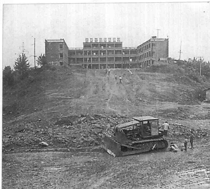
1979年暑假期间，学校集中基建力量，紧张施工，把一条沟壑变成了水泥地面的篮球场。
