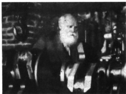
图 1-1 В. П. ВОЛОГДИН 在进行曲轴颈感应淬火
