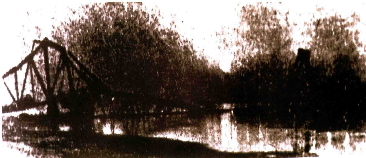
1937年11月中旬，两路日军兵临黄河北岸，对韩复榘实行逼降。韩复榘率领十万大军弃城南逃。12月27日，日军占领省会济南，至次年5月，山东全境沦陷。（图为韩复榘撤逃前炸毁的济南黄河铁路大桥）
