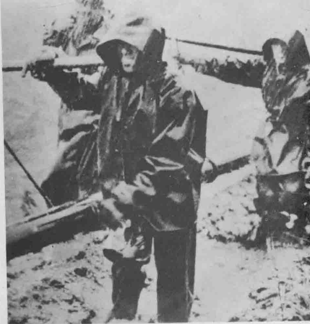
油田建设工人冒雨施工
