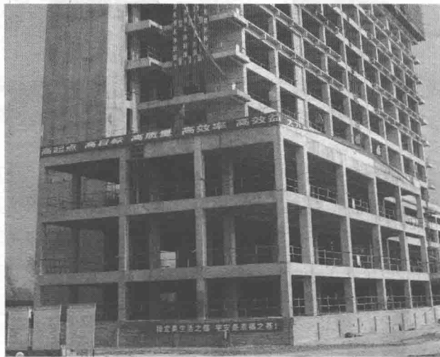
图 1-7 框架—剪力墙结构实例图
