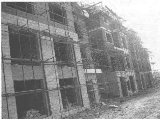
图 1-5 框架结构的实例图
