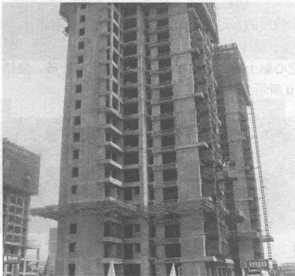
图 1-8 筒体结构实例图
