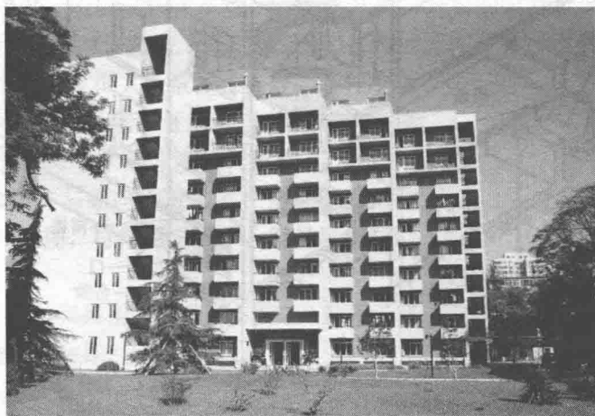
图 1-6 剪力墙结构实例图
