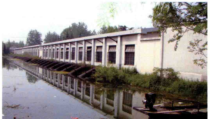
井头大型柴油机组翻水站
