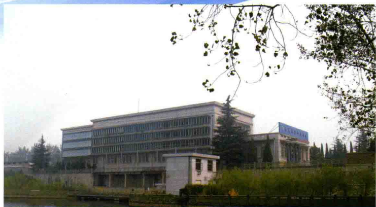
南水北调东线第六梯 级皂河抽水站
