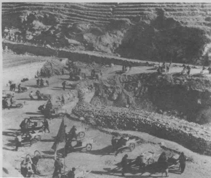
热气腾 腾的石灰冲 工地。
