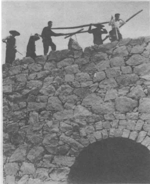
花岗岩石 排拱顶，巧夺 天工托高楼。 图为抬石砌 拱。
