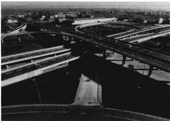
图 1-1 高速公路立交桥
