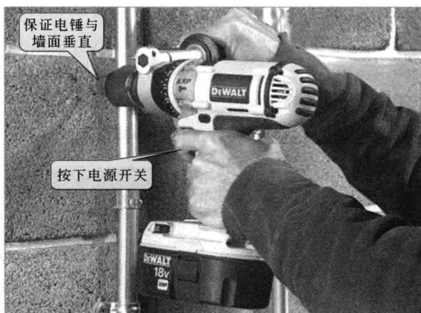
图 1-2 家装电工中电锤的使用
