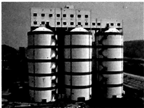
图 1-12 地面煤仓之二
