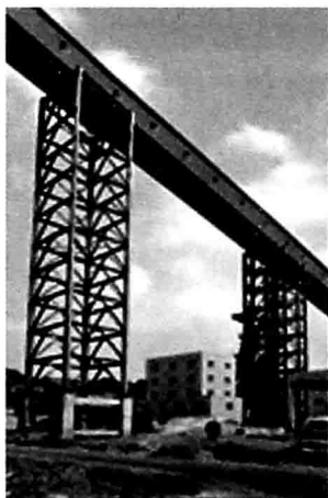
图 1-13 胶带输送机走廊(栈桥)
