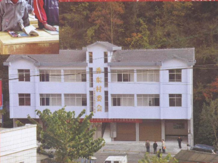
11月11日，由集团公司援建的五峰土家族自治县五峰镇香东村办公楼落成。
