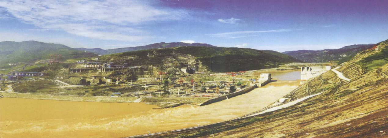
由集团公司承建的国家“十一五”重点工程、我国在建第三大水电站——向家坝水电站一期工程全部完工。
