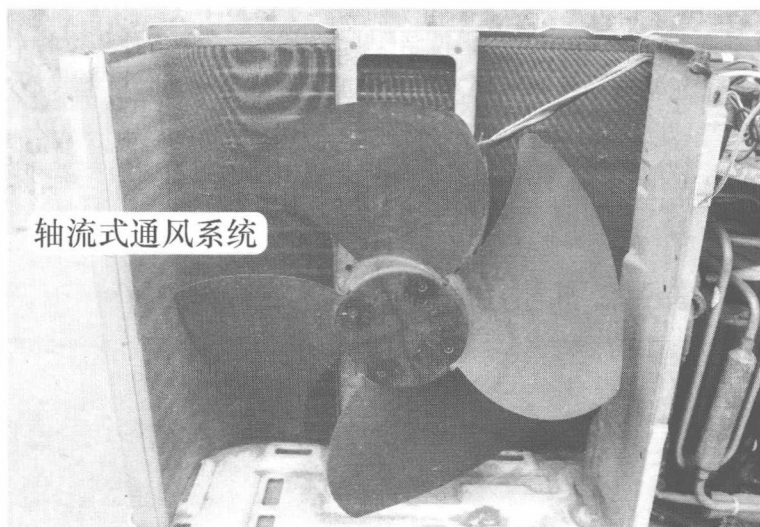
图 1-15 室外机通风系统
