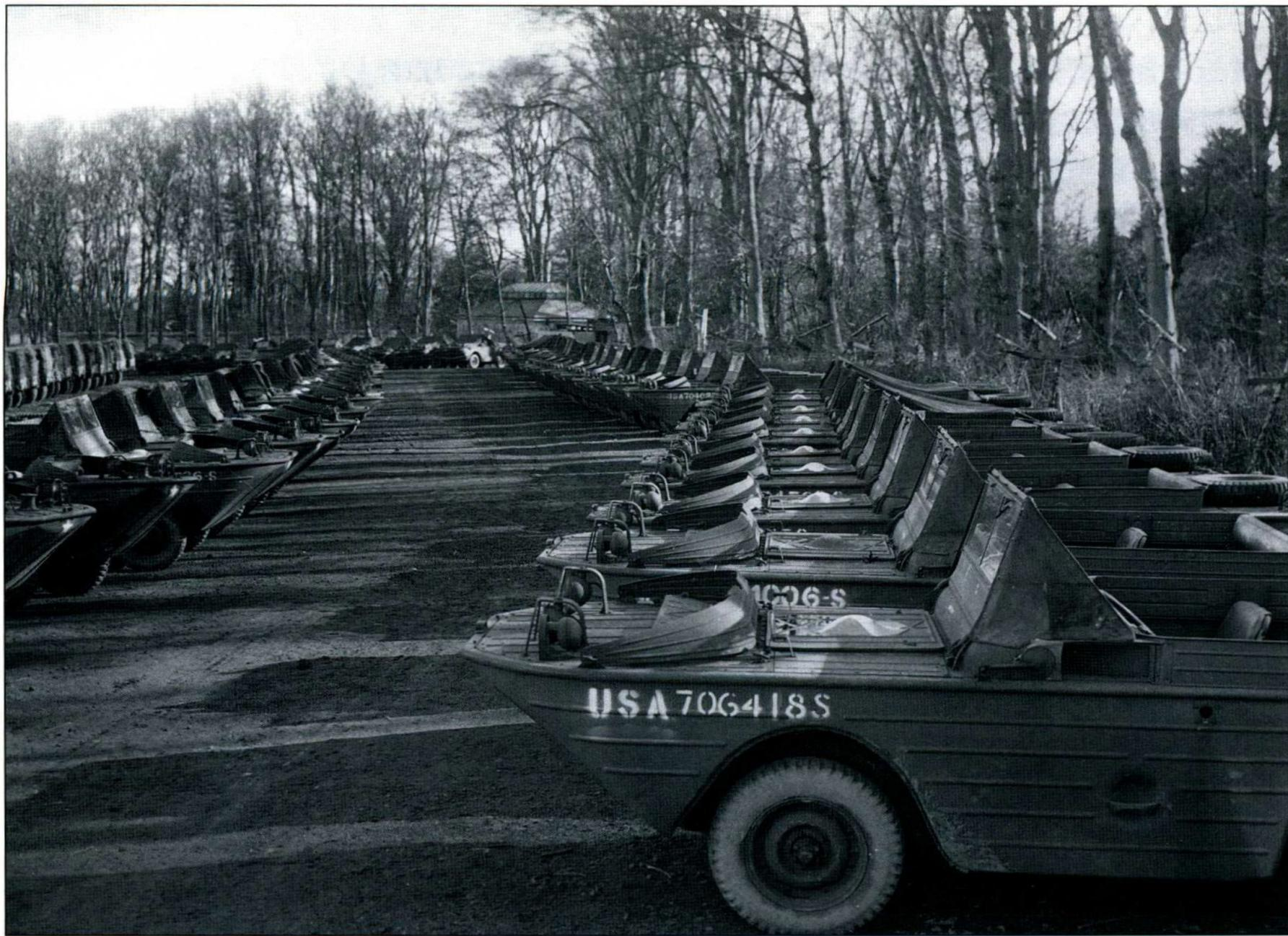
英国某地停车场里的美国陆军0.5吨4×4福特GPA两栖汽车（也被称作“两栖吉普”）。这种车辆和较大的DUKW类似，在1942年—1943年制造了12 000辆。尽管诺曼底战役中使用了这种车辆，但是“两栖吉普”远不如以卡车为基础的DUKW结实，性能也不好。
