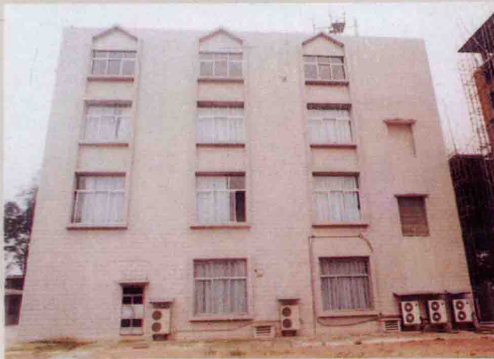
新建人和电讯大楼
