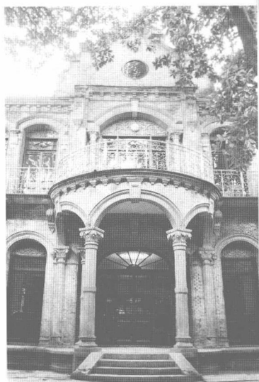
全国重点文物保护单位张石铭旧宅 ——懿德堂西洋楼。
