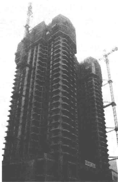
图 1-2 钢筋混凝土结构(施工中)举例
