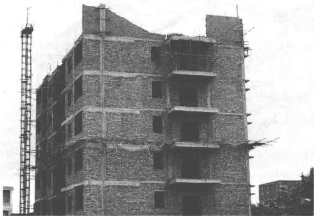
图 1-3 砌体结构(施工中)举例
