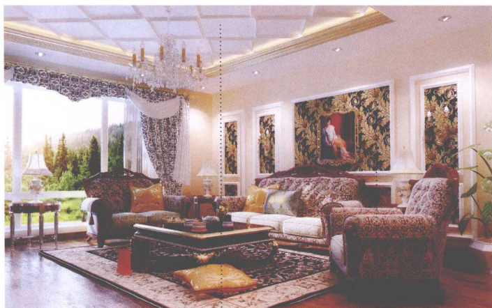
石膏板造型顶
